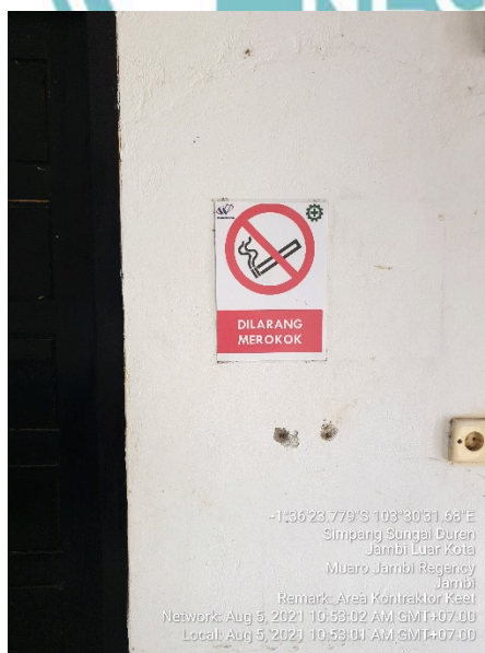
Pemasangan Rambu di dalam ruangan kontraktor keet
