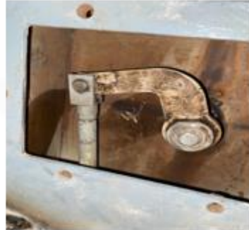
Bagian atas actuator puppet valve sudah di install
