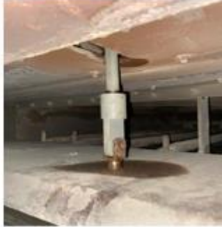
Bagian bawah actuator puppet valve sudah di install
