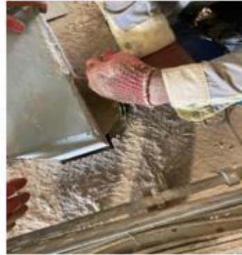
Membuka baut coupling actuator
