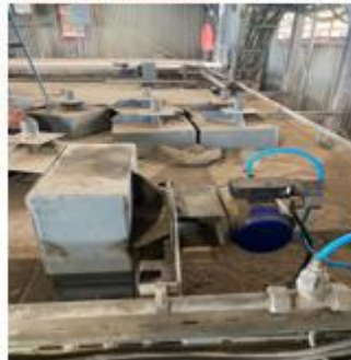
Cover actuator dan puppet valve sudah berhasil di install
