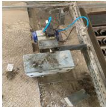
Cover actuator yang baru sudah di install
