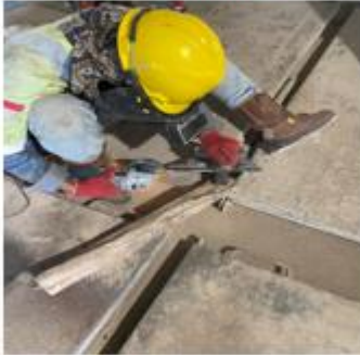
Pengerindaan cover actuator setelah pipa coupling sudah di install
