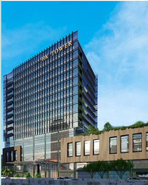
Gedung HK Tower Cawang
