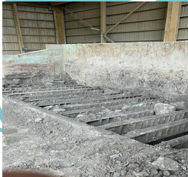
Gambar 1. 3 Kondisi Grizzly Bar dilapangan
