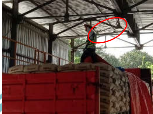
Gambar 1. 1 Posisi Titik Lifeline yang Terlalu Berada di Pinggir Truk
