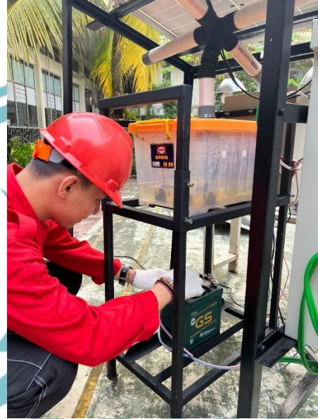
Memasang Kabel Pada Aki/Baterai
