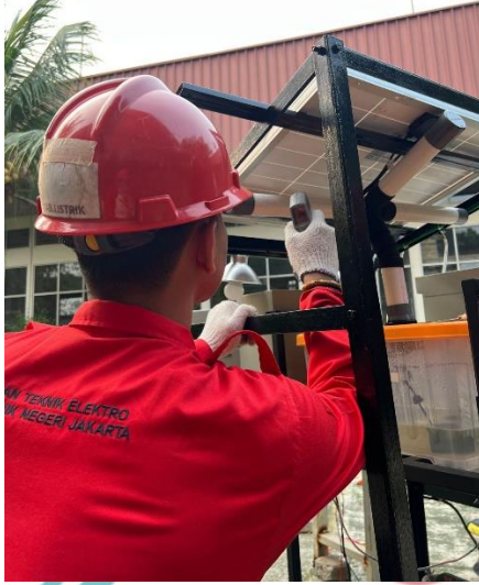
Mengukur Suhu Bagian Bawah Panel Surya
