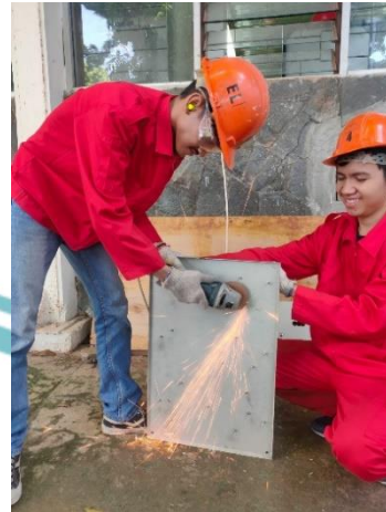
Lampiran 6 Merapihkan Potongan Baut Pada Base Plate Panel
