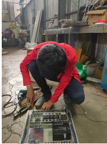
Lampiran 9 Pemasangan Terminal
