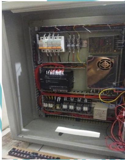
Lampiran 11 Proses Pengkabelan Daya
