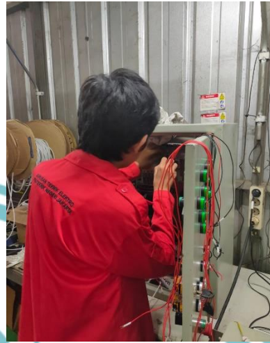
Lampiran 10 Proses Pengkabelan
