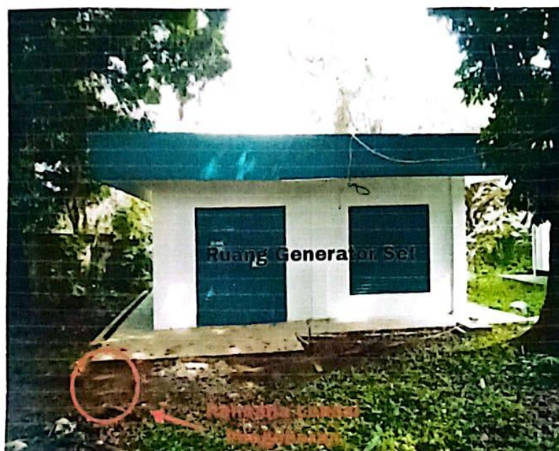
Gambar 2. Ruang Generator Set Politeknik Negeri Jakarta
