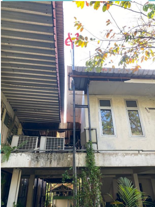
Tiang setelah terpasang dengan Turbin dan Box Panel
