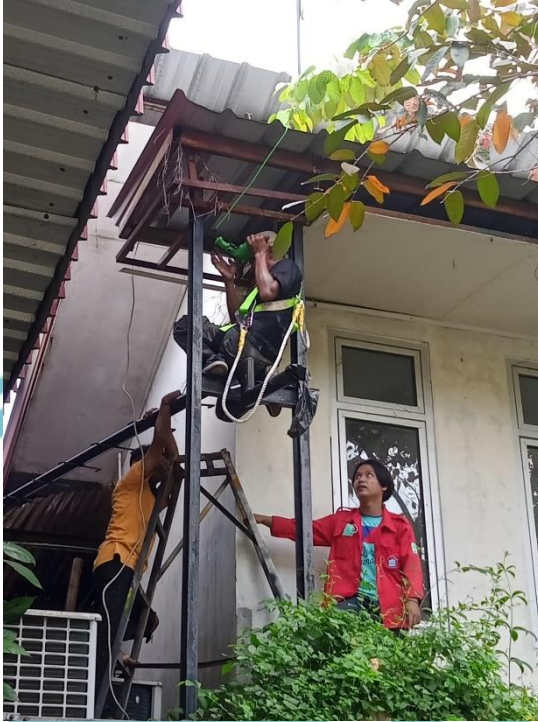
Pembuatan kerangka tiang
