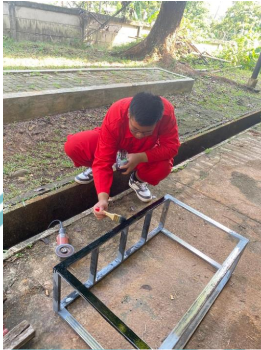
Proses Pengecatan Kerangka Elevator
