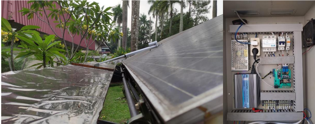
Gambar 3. Realisasi Panel Surya dengan Reflektor Otomatis dan Panel Box
