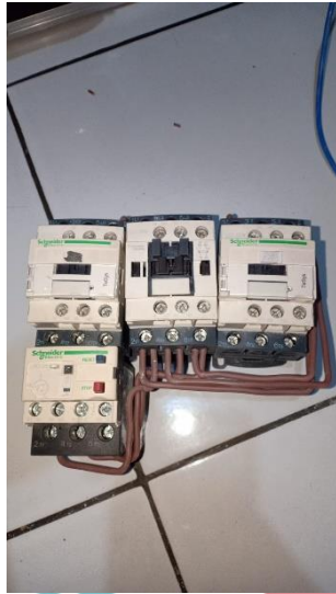
Proses pengkabelan daya
