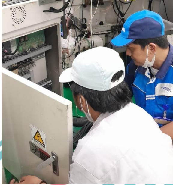
Gambar L- 3 Foto saat melakukan Wiring Relay
