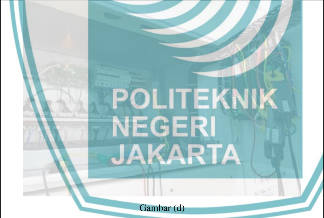
Gambar (c) dan (d). Tampak Instalasi Alat Power Quality Analyzer (PQA) Pada Panel Metering
