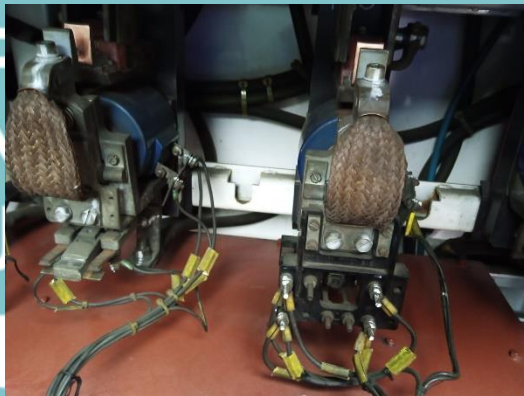
→ Power Kontaktor yang dibersihkan
