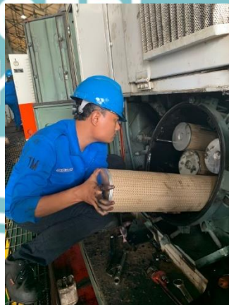
→ Pemasangan filter oli yang baru.
