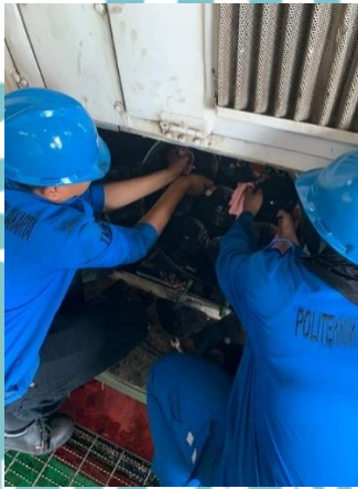
→ Proses melepas filter oli mesin yang lama.
