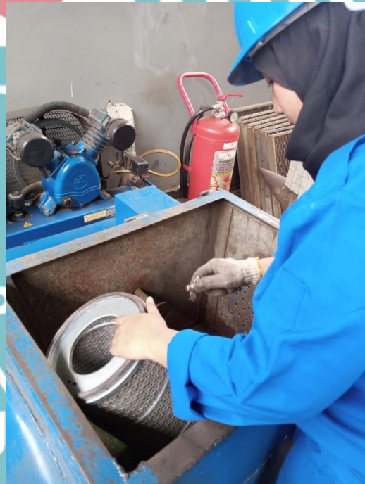
→ Pembersihan filter engine menggunakan angin kompresor yang berjumlah 12 buah.
