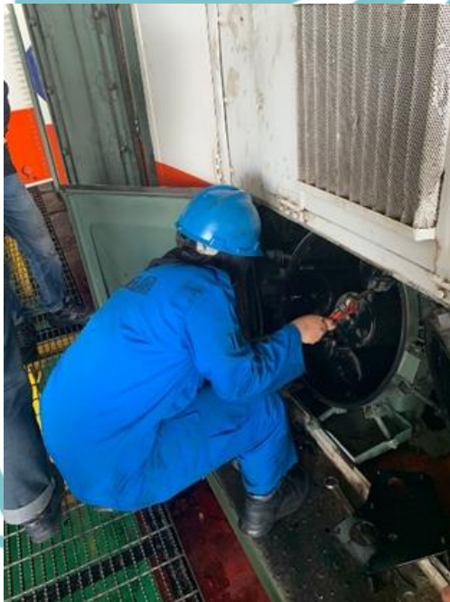
Proses pemasangan filter oli mesin yang baru
