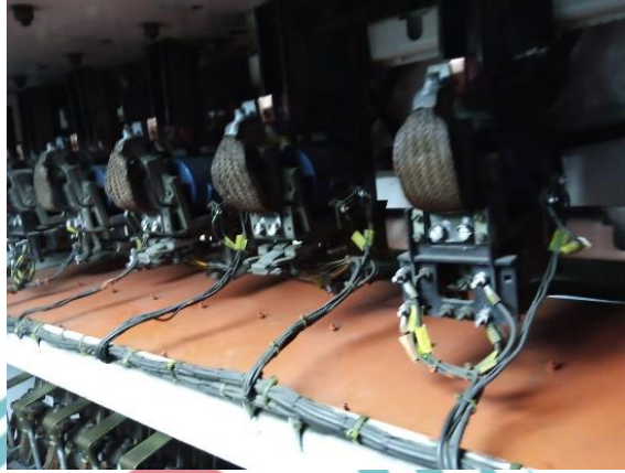
Pembersihan tembaga pada kontaktor 70V dengan amplas kasar 60
