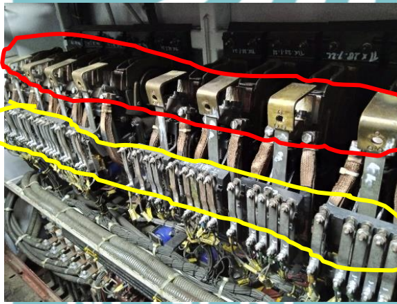
Pembersihan tembaga pada kontaktor 70V dengan amplas kasar 60
