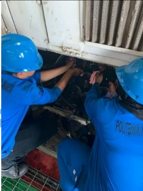
Proses pelepasan filter oli mesin
