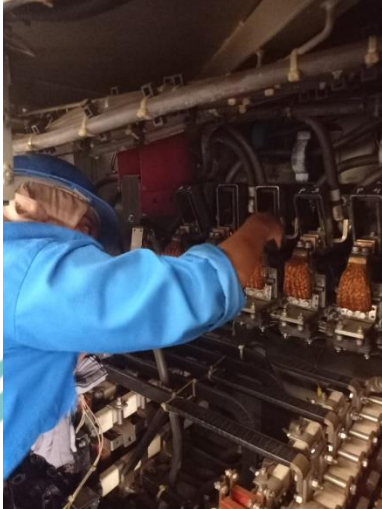
Proses pemasangan carbon brass
