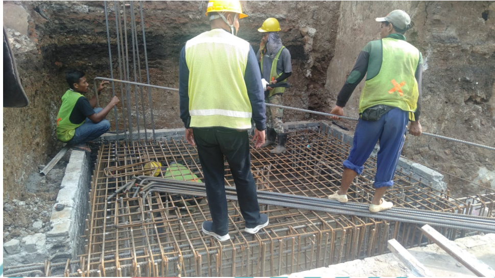
Gambar 4. 20 Pekerjaan Pembesian Pile Cap (Sumber : Dokumentasi Pribadi)
