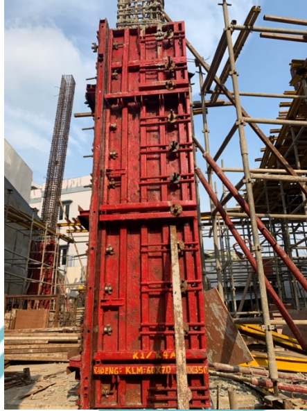
Gambar 4. 35 Bekisting Kolom (Sumber : Dokumentasi Pribadi)
