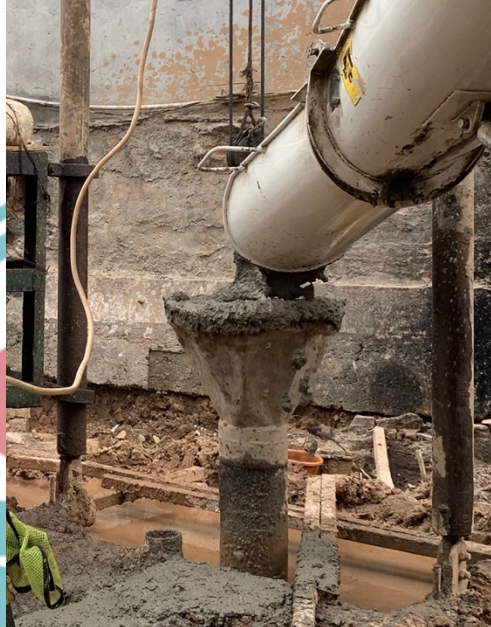
Gambar 4. 8 Concrete Bucket Pengecoran Bor Pile (Sumber : Dokumentasi Pribadi)
