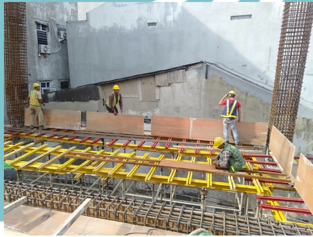
Gambar 4. 38 Pekerjaan Bekisting Balok dan Plat Lantai (Sumber : Dokumentasi Pribadi)
