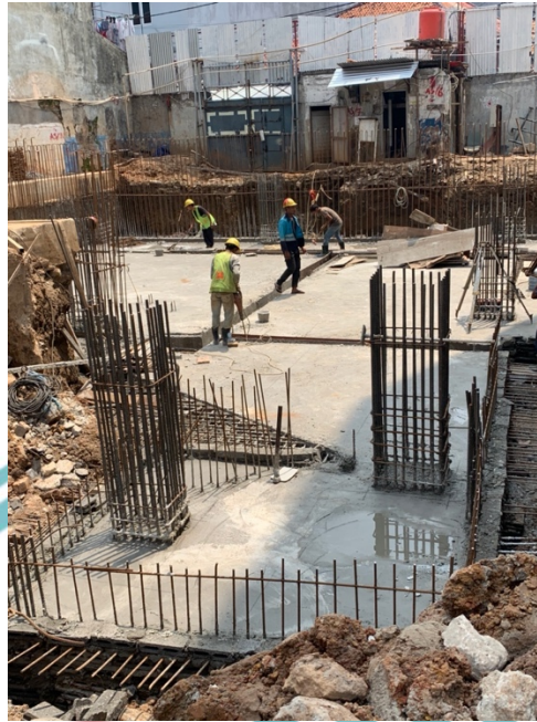
Gambar 4. 21 Proses Curing (Sumber : Dokumentasi Pribadi)
