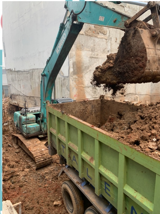
Gambar 4. 15 Pekerjaan Galian (Sumber : Dokumentasi Pribadi)
