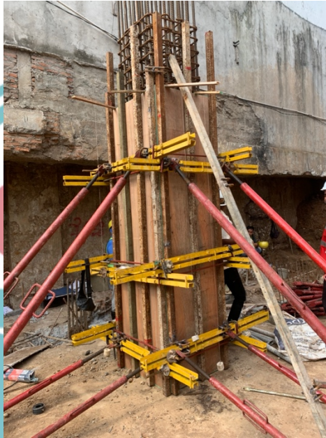
Gambar 4. 37 Pemasangan Bekisting Kolom (Sumber : Dokumen Pribadi)
