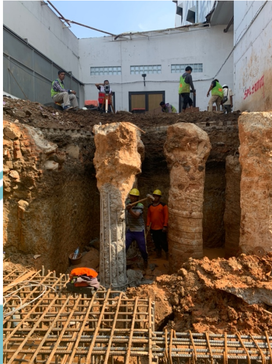
Gambar 4. 16 Pekerjaan Pembobokan Tulangan Bor Pile (Sumber : Dokumentasi Pribadi)
