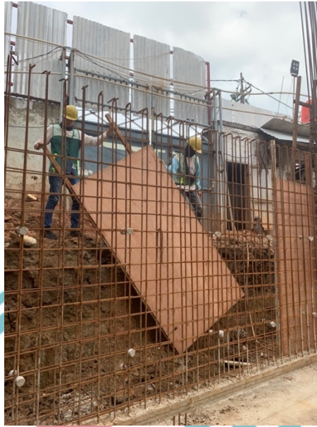
Gambar 4. 27 Pekerjaan Bekisting Retaining Wall (Sumber : Dokumentasi Pribadi)
