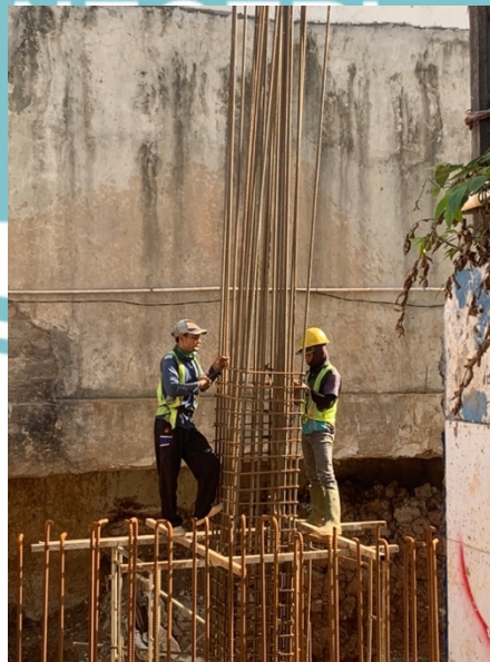
Gambar 4. 36 Pekerjaan Pemesian Kolom (Sumber : Dokumentasi Pribadi)
