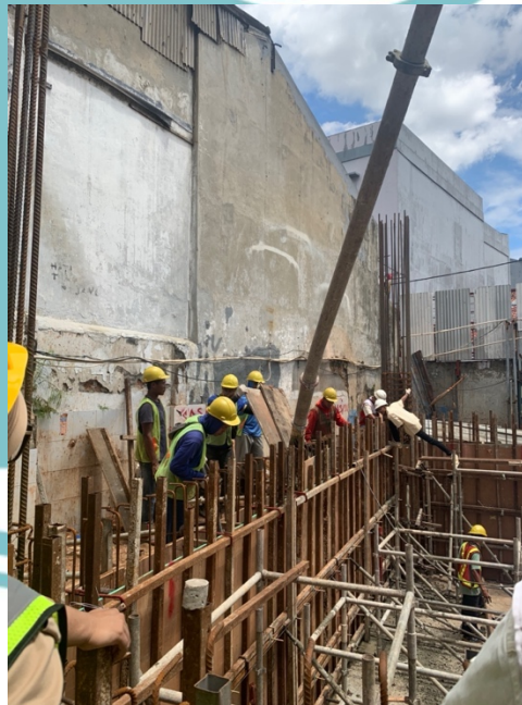
Gambar 4. 29 Pekerjaan Pengecoran Retaining Wall (Sumber : Dokumentasi Pribadi)
