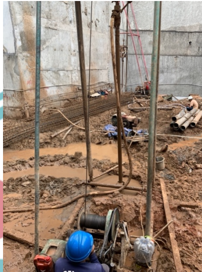
Gambar 4. 11 Pengeboran Bor Pile (Sumber : Dokumentasi Pribadi)
