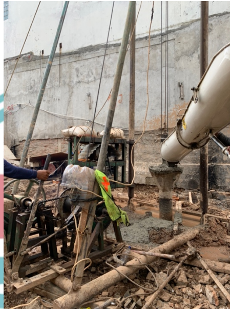
Gambar 4. 14 Pengecoran Pondasi Bor Pile (Sumber : Dokumentasi Pribadi)
