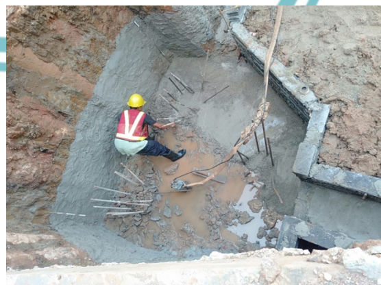
Gambar 4. 17 Pembuatan Lantai Kerja (Sumber : Dokumentasi Pribadi)
