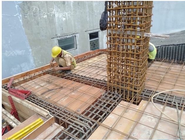
Gambar 4. 39 Pekerjaan Pembesian Balok dan Pelat Lantai (Sumber : Dokumentasi Pribadi)
