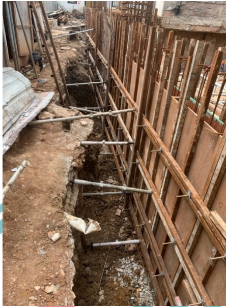
Gambar 4. 28 Pembuatan Bekisting Retaining Wall (Sumber : Dokumentasi Pribadi)
