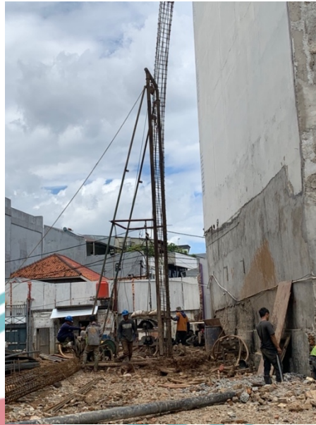
Gambar 4. 12 Pemasangan Tulangan Bor Pile (Sumber : Dokumentasi Pribadi)
