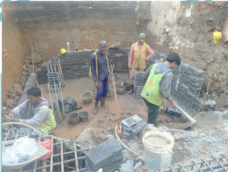
Gambar 4. 19 Pekerjaan Bekisting Pile Cap (Sumber : Dokumentasi Pribadi)
