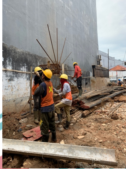
Gambar 4. 9 Pembuatan Tulangan Spiral Bor Pile (Sumber : Dokumentasi Pribadi)
