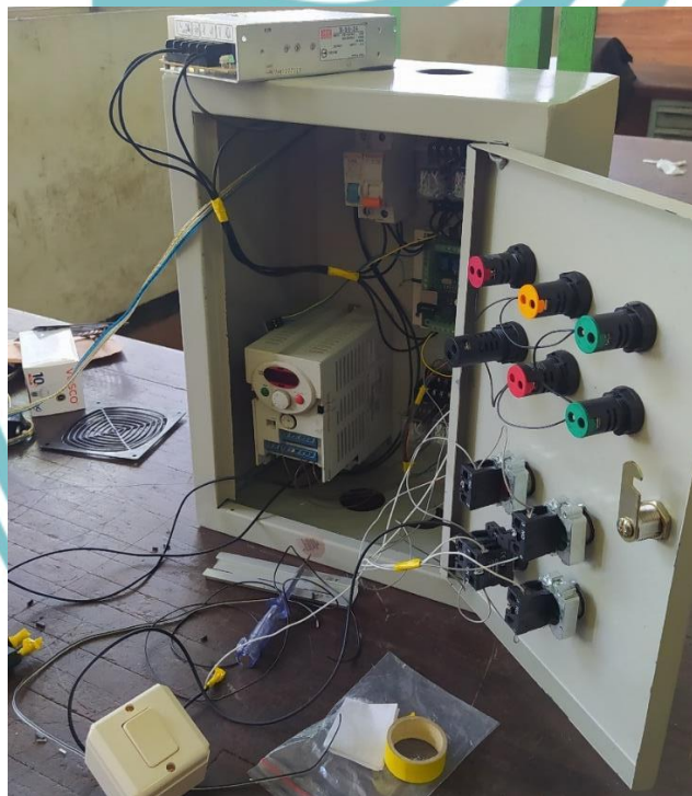
Gambar L. Pemasangan komponen pada panel
