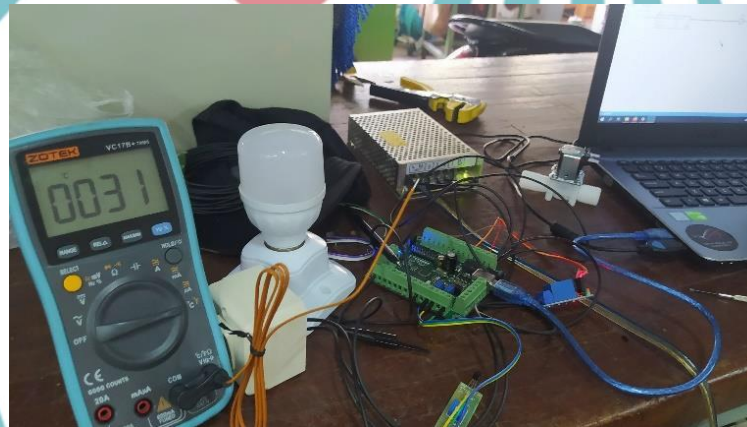
Gambar L. Pemeriksaan kondisi alat sebelum instalasi
