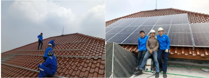
Pemasangan Panel Surya On-Grid di Direktur Utama Garuda
