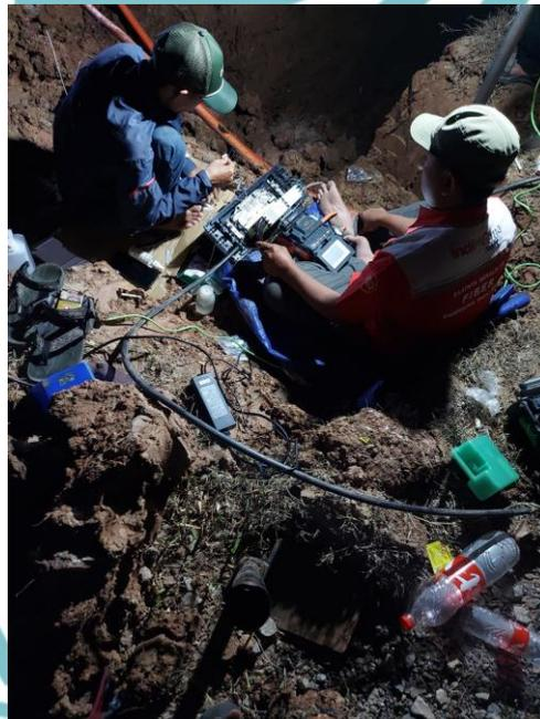
Gambar 3. 18 Proses Penyambungan Kabel
