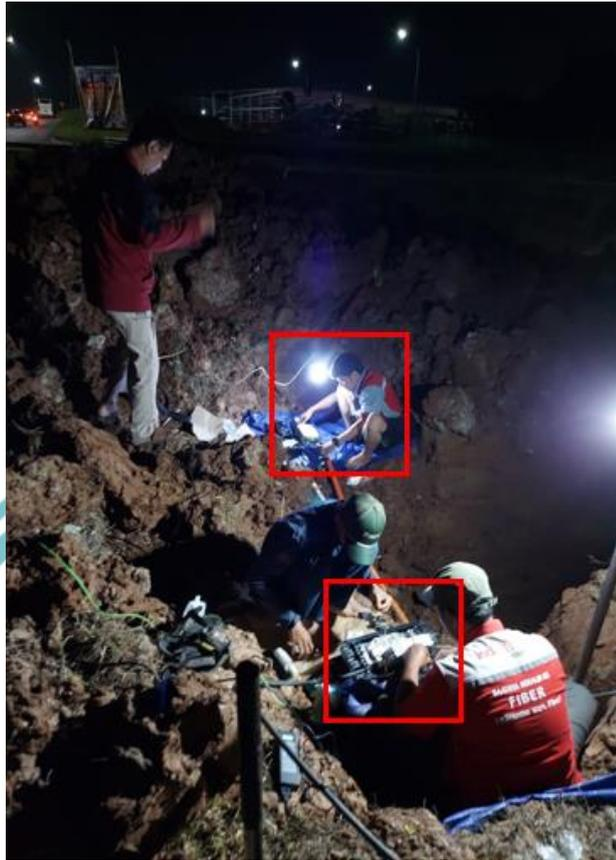
Gambar 3. 17 Titik Tempat Penyambungan Kabel
