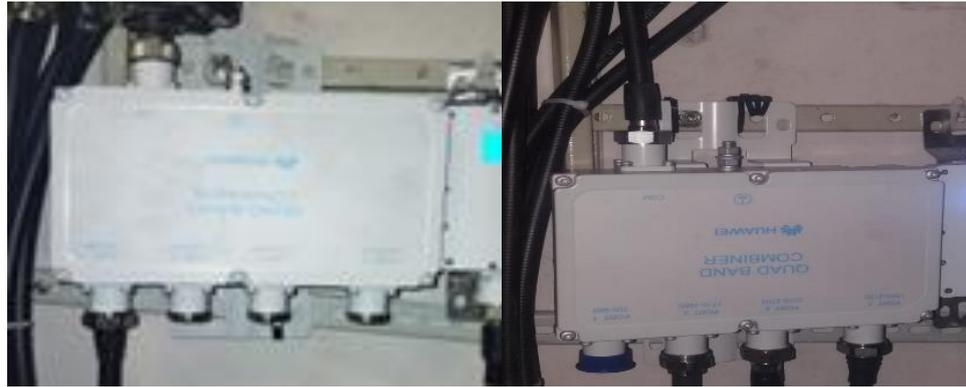
Gambar 3. 8 kabel *feeder* dan *port* sebelum dan sesudah diganti
