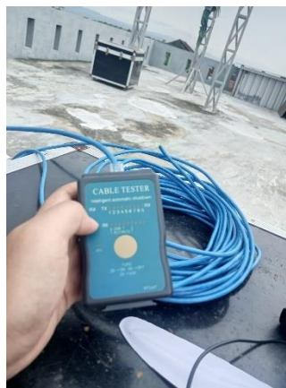
Gambar 15. Pemasangan Kabel LAN
