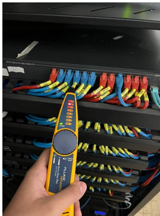
Gambar L-4. 6 Tracing kabel untuk mencari port yang terhubung
