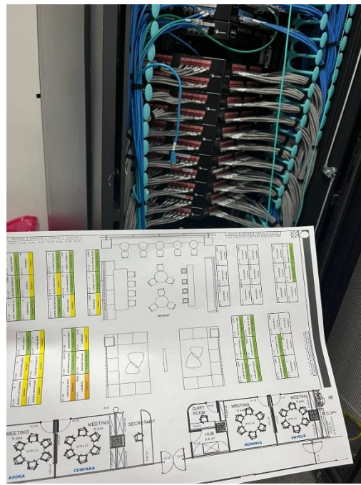
Gambar L-4. 2 Konfigurasi Switch untuk LAN di tiap meja
